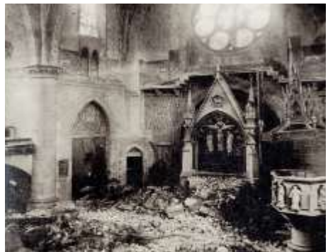
Zerstörung der Einrichtung im Innenraum
