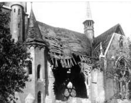
Zerstörung der Ostwand durch Luftmine
